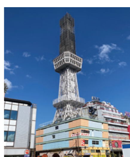
改修工事が進む別府タワー
